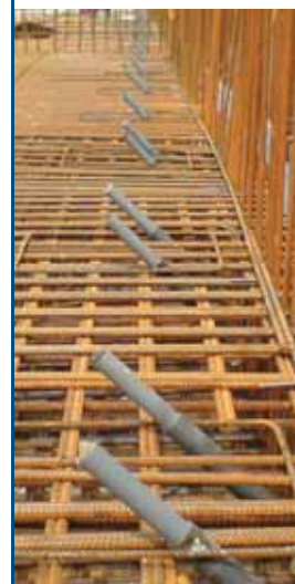
Doppelanker eingebaut
