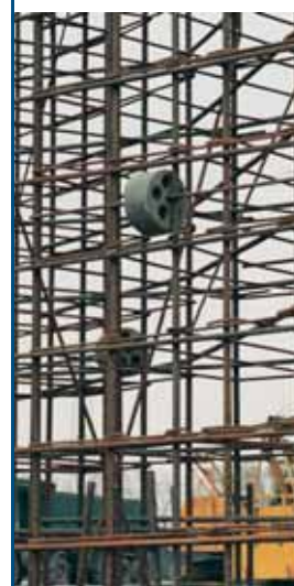
Doppelanker eingebaut
