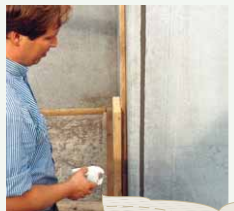
Verpressen von Fugen bei Hohlwänden
