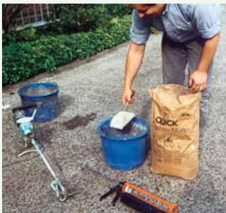
Einsumpfen des Expansiv-Mörtel
