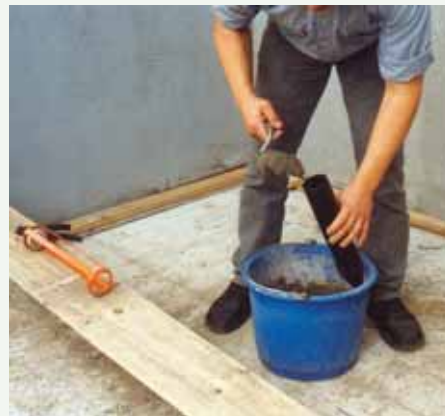
Verpressen von Fugen bei Hohlwänden
