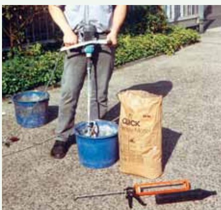
An- und Aufrühren des Expansiv-Mörtels
