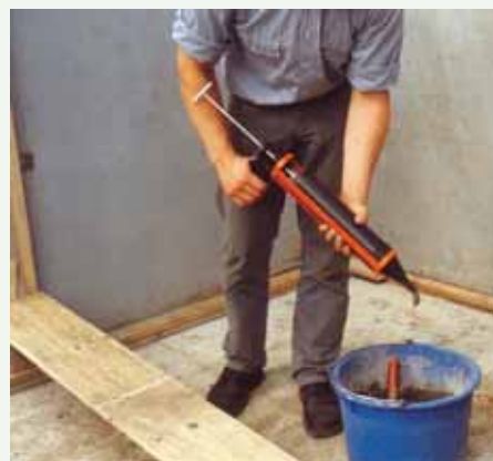
An- und Aufrühren des Expansiv-Mörtels
