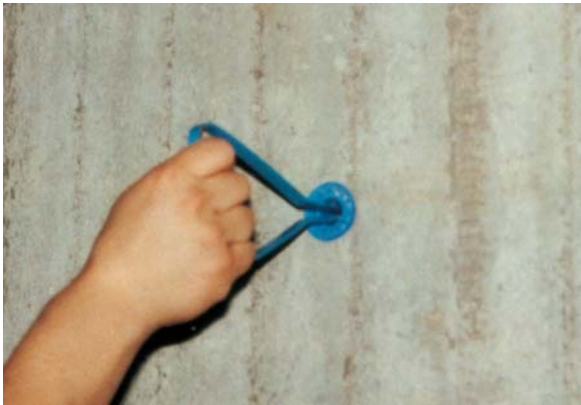
Die Dichtungskappe (weich) wird entfernt
