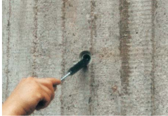
Das Distanzrohr wird gereinigt
