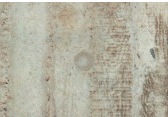
Der Verschlussstopfen, hier der »Quick-VK-DK 22/10/50«, wird in den Kleber+Mörtel leicht drehend eingedrückt. Den herausquellenden Kleber+Mörtel abbinden lassen und dann mit einem scharfen Spachtel abschneiden.
