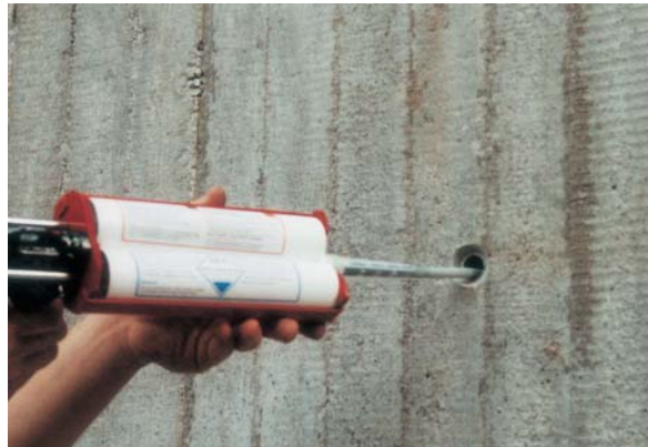
Der KarPox-Kleber+Mörtel wird mit der Hand- oder Luftdruckpresse eingebracht
