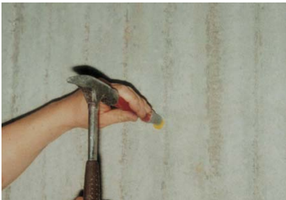
Der Schlagstopfen (Widerlager) wird eingetrieben
