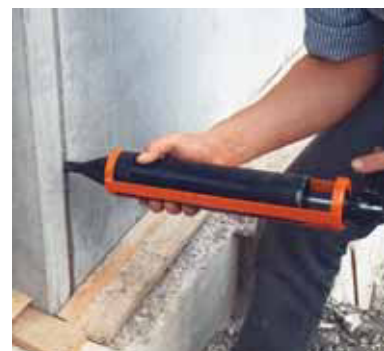
Verpressen von Fugen bei Hohlwänden
