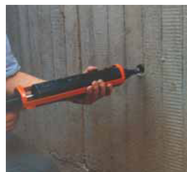
Vermörteln von Konenlöchern
