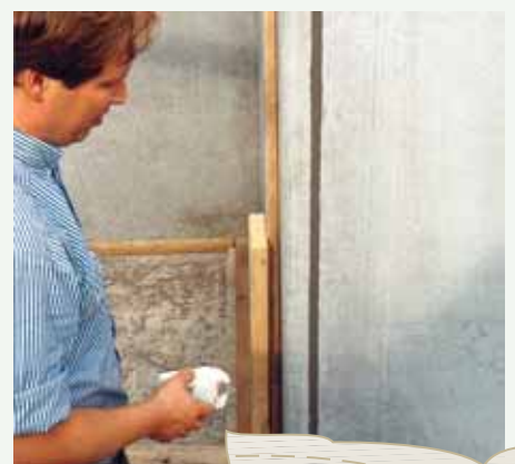
Verpressen von Fugen bei Hohlwänden
