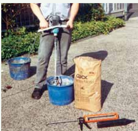
An- und Aufrühren des Expansiv-Mörtels
