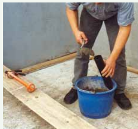
Verpressen von Fugen bei Hohlwänden
