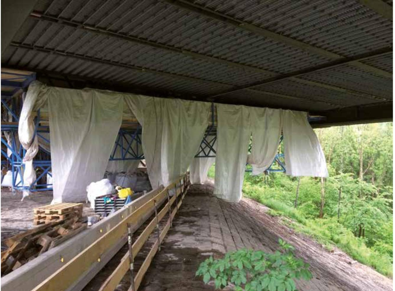
Arbeitsbühne für Korrosionsschutz-Arbeiten
