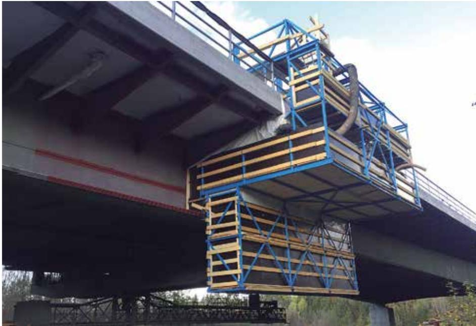
Äußere Arbeitsbühne für den Korrosionsschutz von Stahlbrücken
